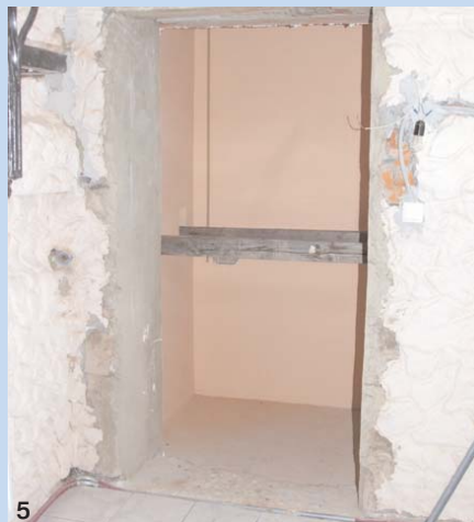
5. Перед началом крепления элементов конструкции лифта в шахте монтажники установили специальные леса
