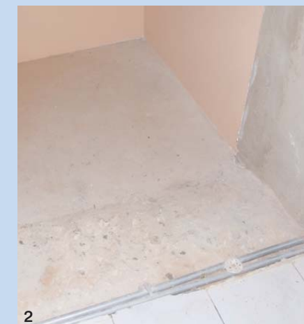
3. Приямок под данную модель лифта требуется совсем небольшой — глубиной всего 100 мм
