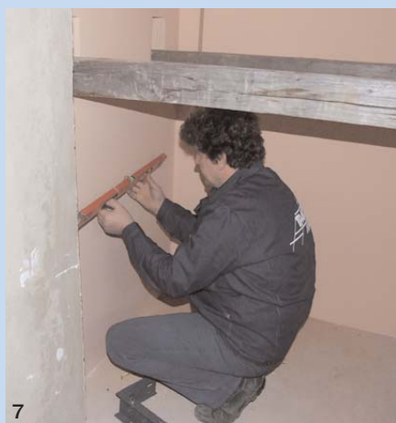
7. С помощью уровня рабочие проверяют размеры шахты лифта, а также вертикальность стен
