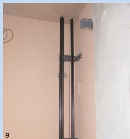
9. Когда установлены кронштейны и направляющие противовеса, монтируют буфер противовеса и сам противовес
