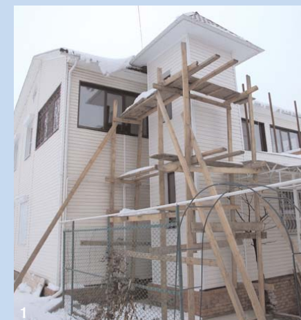
1. После завершения строительных работ шахту лифта снаружи, как и весь дом, обшили сайдингом
