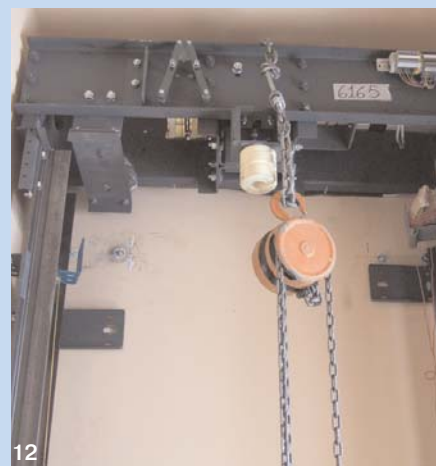
12. Лифт движется с помощью электропривода, перемещающего трос, на котором висит каркас кабины
